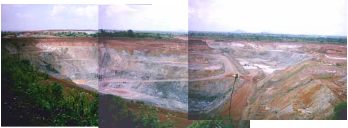
รูปที่ 2 ขุมเหมือง “สุริยันต์” ที่อยู่ตอนกลางก่อนไปทางตะวันตกของหมู่เหมือง
