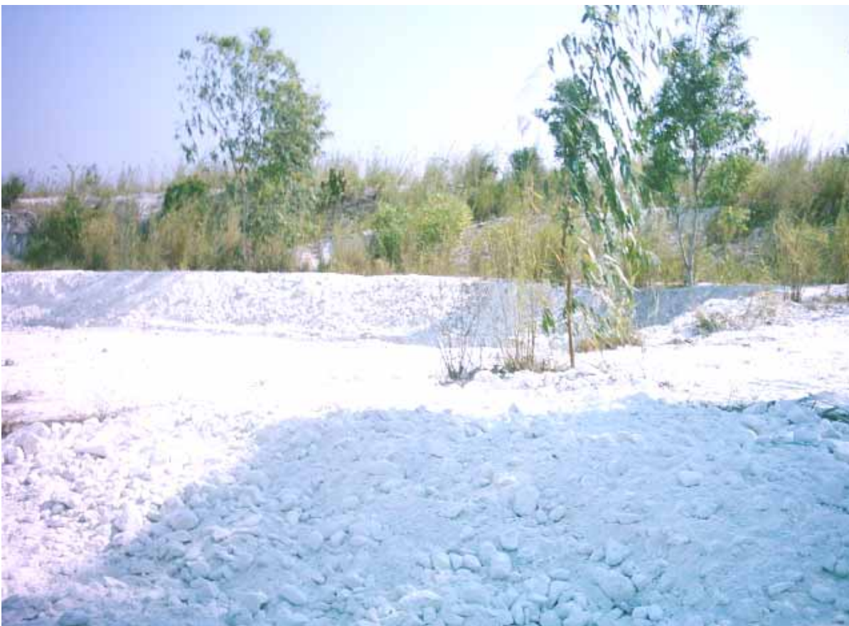
รูปที่ 8 หนึ่งในแนวคันดินที่สร้างไว้เพื่อดักตะกอนและกักน้ำในฤดูฝน
