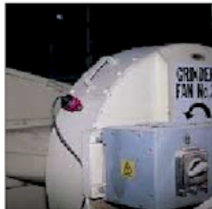
รูปที่ 7 แสดงเซ็นเซอร์ตรวจวัดถุงกรองที่รั่วในระบบการกรองแบบ DCE
