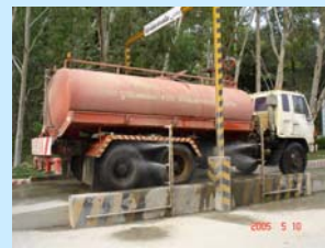
ลานล้อยที่มีระบบฉีดน้ำล้างอัตโนมัติ และการระบายน้ำลงสู่บ่อตกตะกอน
