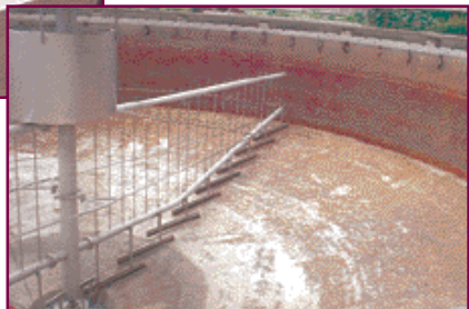
ภายในบ่อเกรอะ
