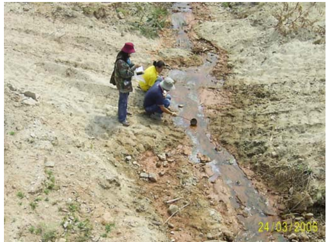
รูปที่ 9 ลำธารที่ไหลซึมมาจากอ่างเก็บน้ำ ด้านบน (SMW-4)
