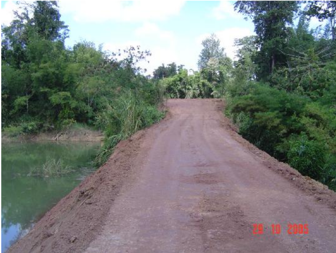
รูปที่ 2 สันเขื่อนปอแก้วเก็บน้ำใสที่ได้มีการดำเนินการปรับปรุงคันทำนบแล้ว
