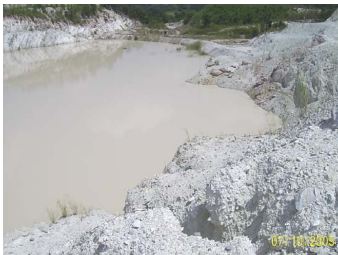
รูปที่ 11 บริเวณขอบของแอ่งน้ำยังมีสภาพ ผิวที่เปลี่ยน น้ำฝนสามารถชะล้าง เอาเม็ดดินลงไปเพิ่มเติมได้
